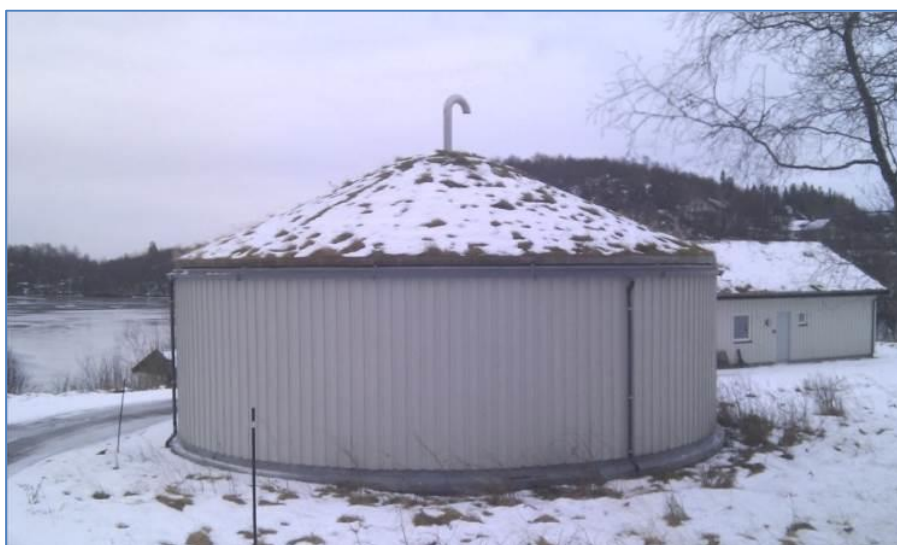
Oppeid høydebasseng, vannbehandlingsanlegg og kilde (Hovedplan VA Hamarøy/Asplan Viak)
