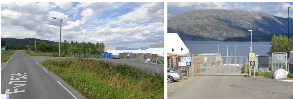
Figur 4: Dagens situasjon fra Hellelandsveien. Foto: Google Maps, august 2022.
