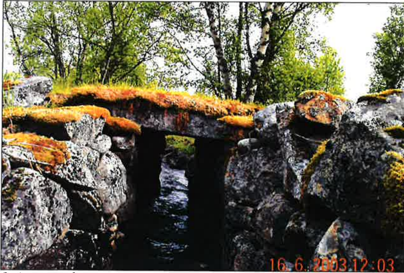
Steinsatt grøft og stikkrenne. (Foto: Nordland fylkeskommune)
