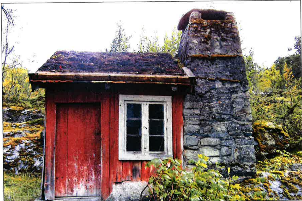
Smie, fasade øst. Etter restaurering, 2005. (Foto: Nordland fylkeskommune)
